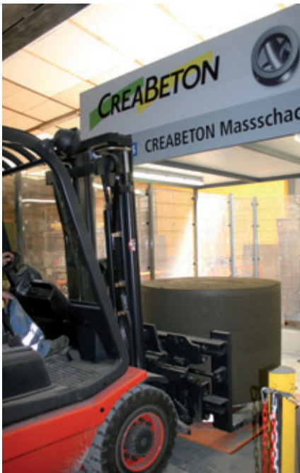
Posizionamento di un greggio di pozzetto in calcestruzzo sull'anello di fissaggio della stazione di lavoro
