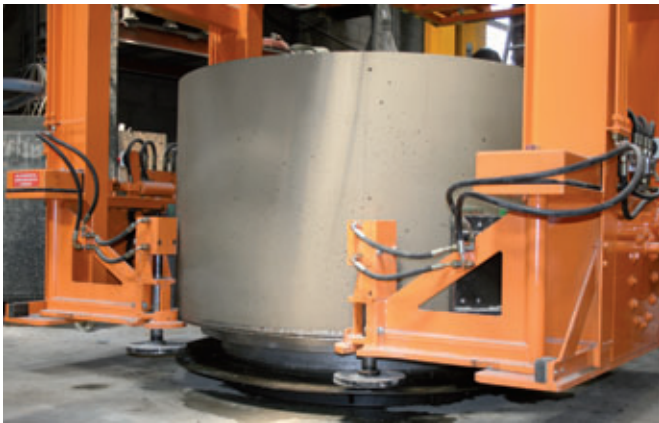
Rimozione del cappello di supporto
